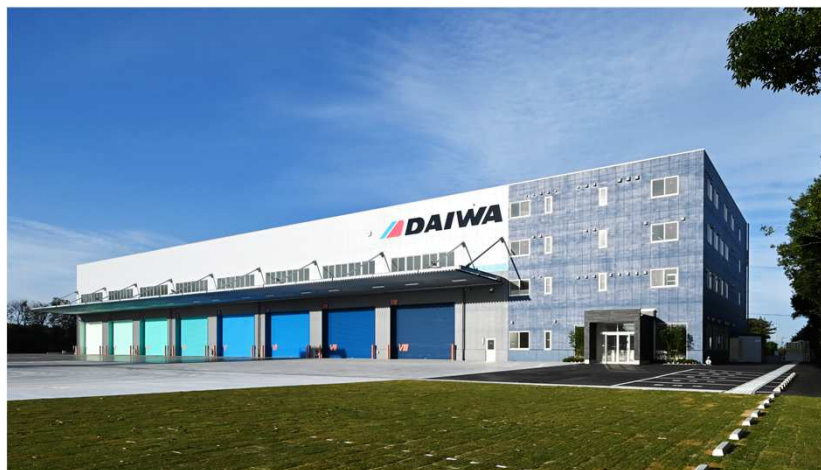
大和機工株式会社 常滑新工場
