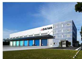
大和機工株式会社 常滑新工場
