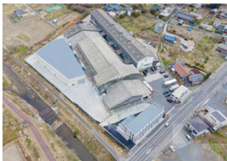
某物流センター及び事務所
