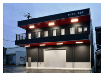
株式会社安達組 倉庫・事務所
