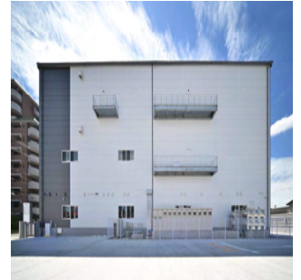
完了検査・竣工
