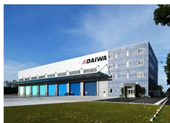
大和機工株式会社 常滑新工場
