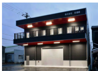
株式会社安達組 倉庫・事務所
