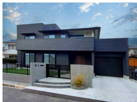
愛知県刈谷市 K様邸 ・竣工 令和4年4月 ・構造 木造2階建 ・延床面積 136.89㎡
