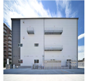
完了検査・竣工
