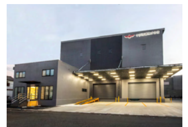
中京陸運株式会社 春日定温倉庫 (2号棟)
