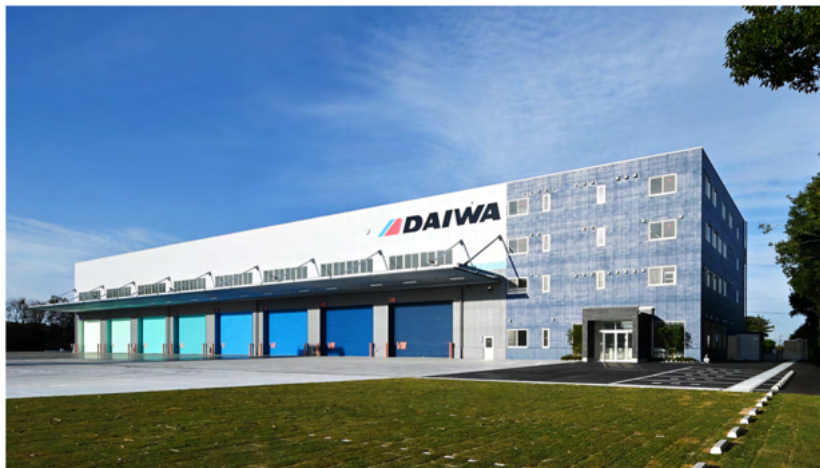
大和機工株式会社 常滑新工場
