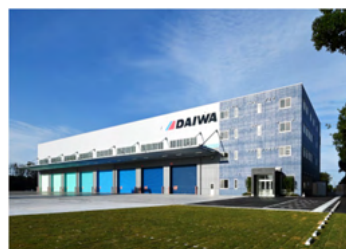
大和機工株式会社 常滑新工場
