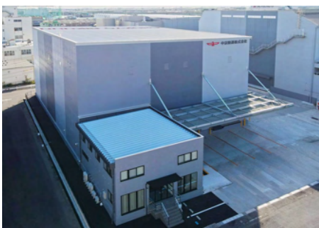
中京陸運株式会社 春日定温倉庫（2号棟）
